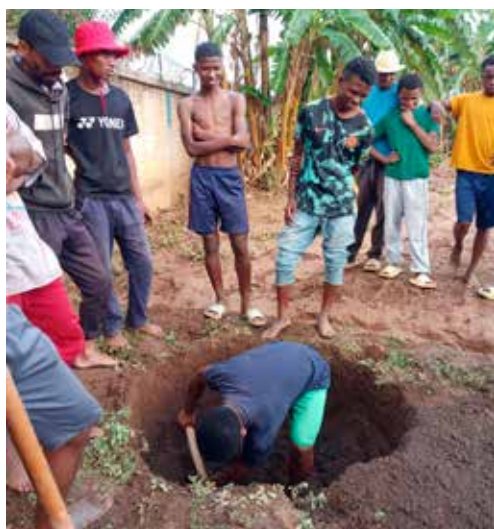
Construction de deux nouveaux puits avec les jeunes
