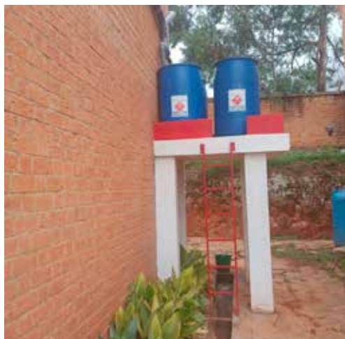
De nouvelles cuves de récupération d'eau pour Tana
